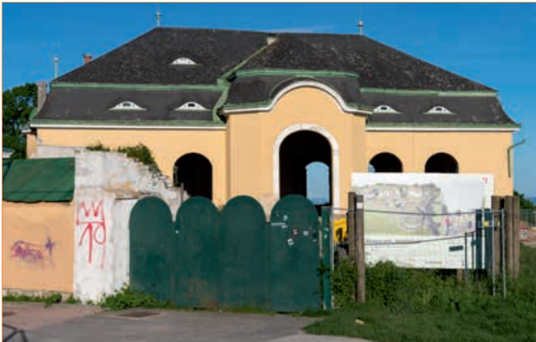
Umbauarbeiten am Cobenzl
