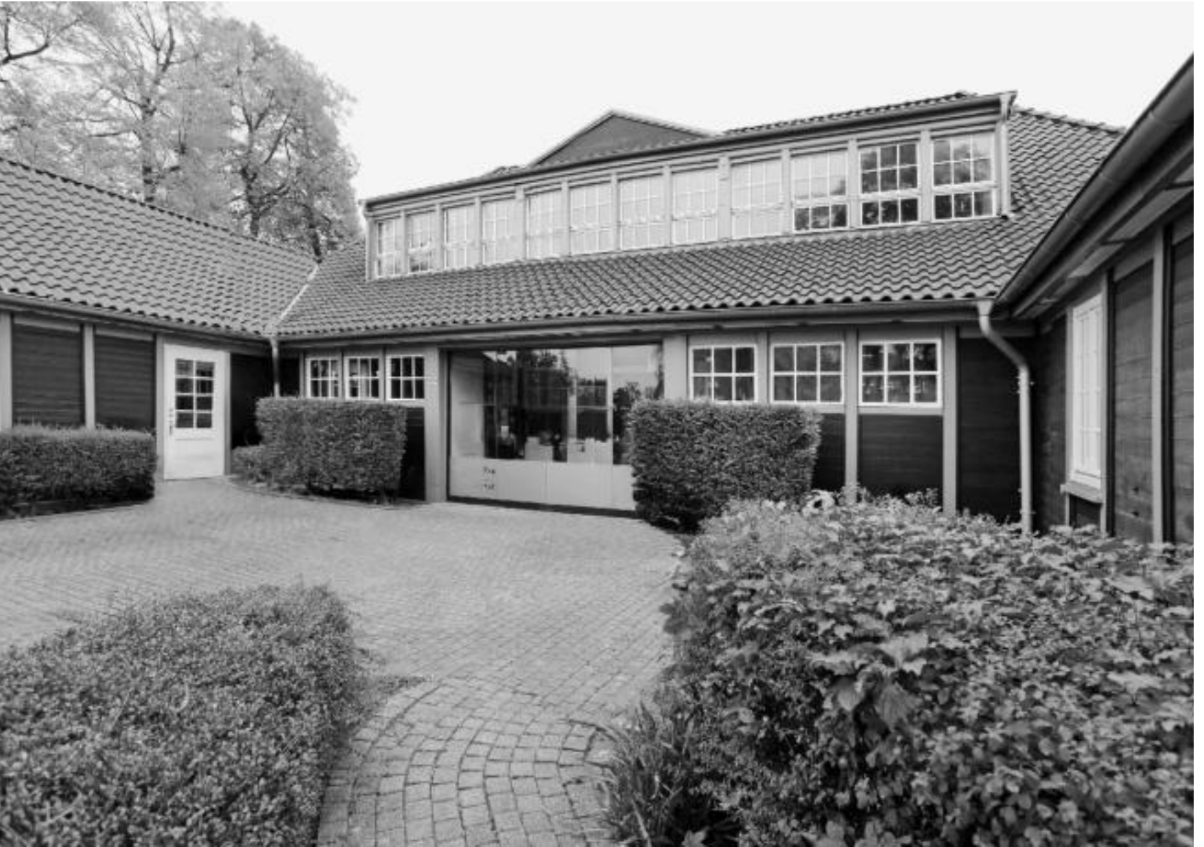
22 Essen, Jugendhalle Schonneck, Saatbruchstraße 52, Büro Schreiterer & Below, Baujahr 1914
