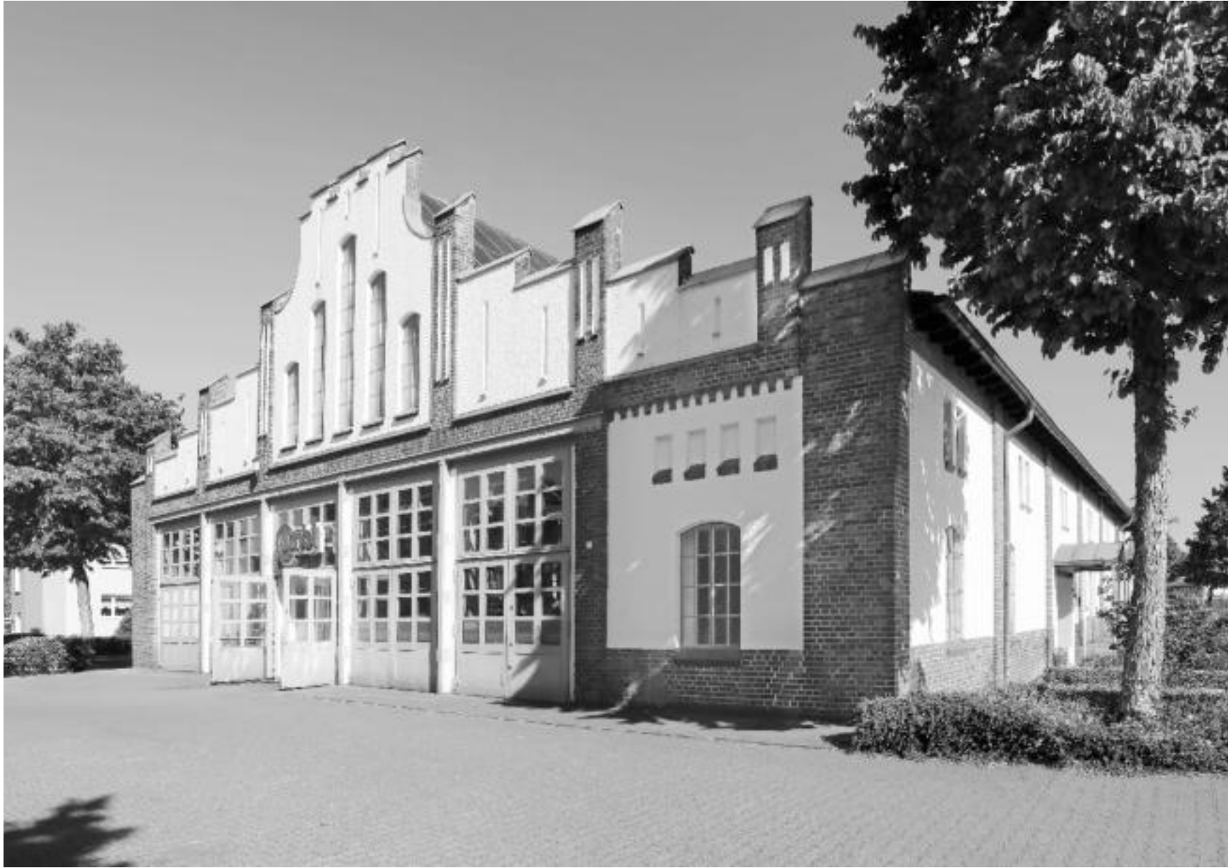
Paderborn, Straßenbahndepot PESAG, Rolandsweg/Ecke Nordstraße, Architekt unbekannt, Baujahr 1910/1911
