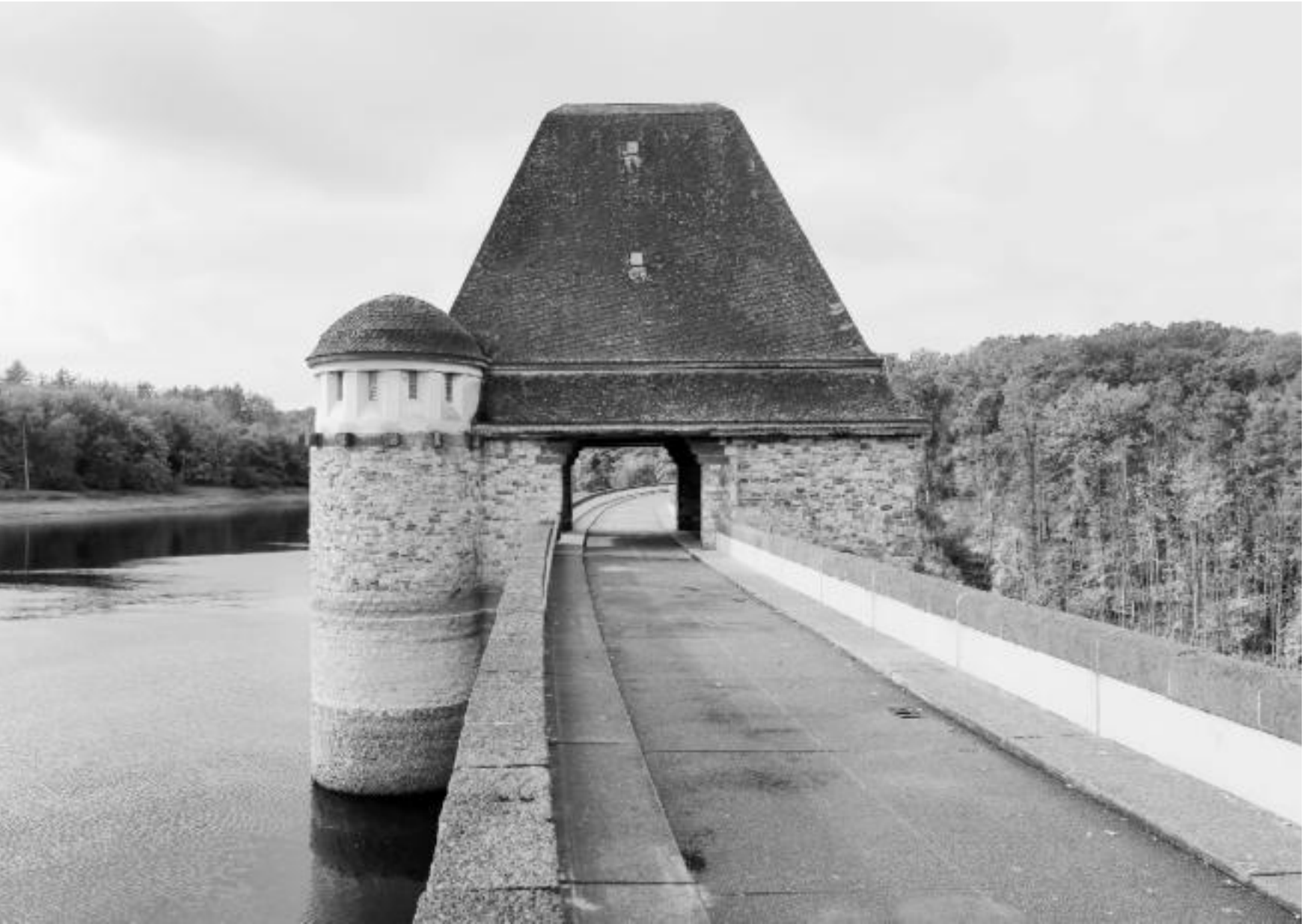
24 Mohnesee, Stauwerk, Möhnestraße 10, Franz Brantzky, Baujahr 1913
