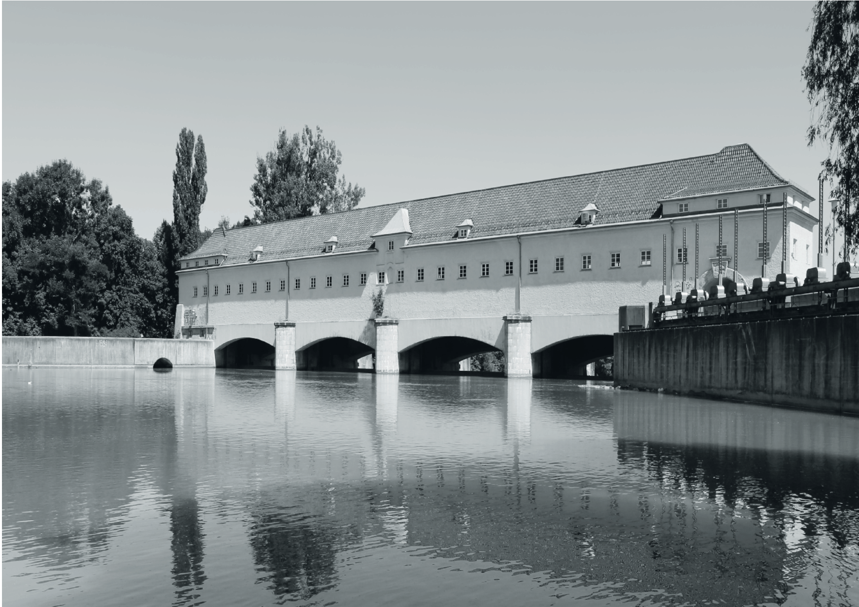
München, Wehranlage Oberföhring, Max-Halbe-Weg, Baujahr 1920–1924.
