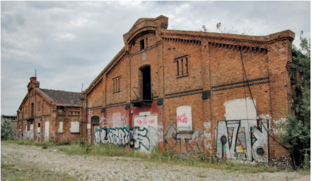
Gemauerte Rinderställe. Die Fronten wurden inzwischen saniert, die dahinter liegenden Gebäude abgerissen.
