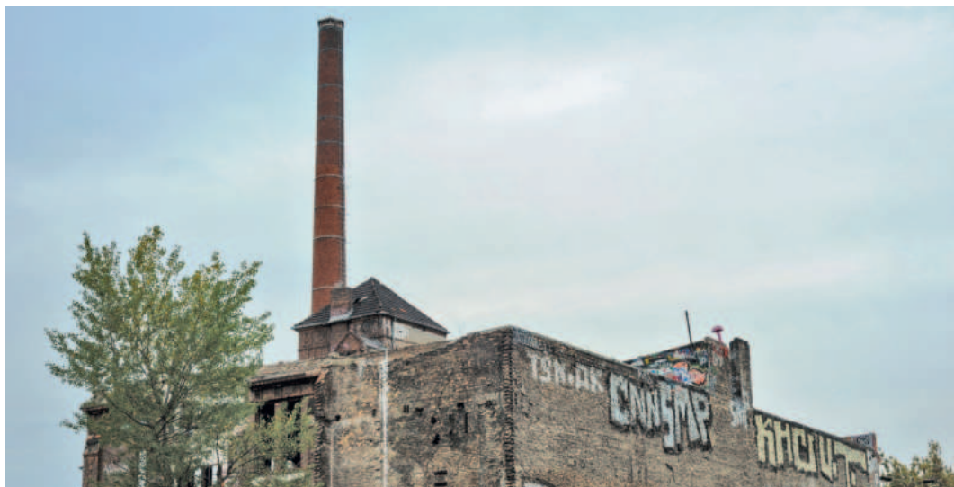
Schornstein der Eisfabrik.
