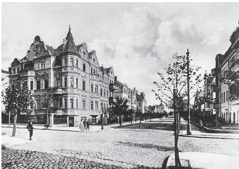
Blick von der Hentig- in die Dorotheastrasse, 1915
